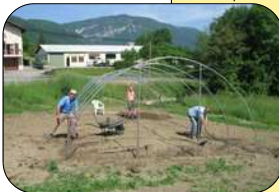
Installation de la serre
