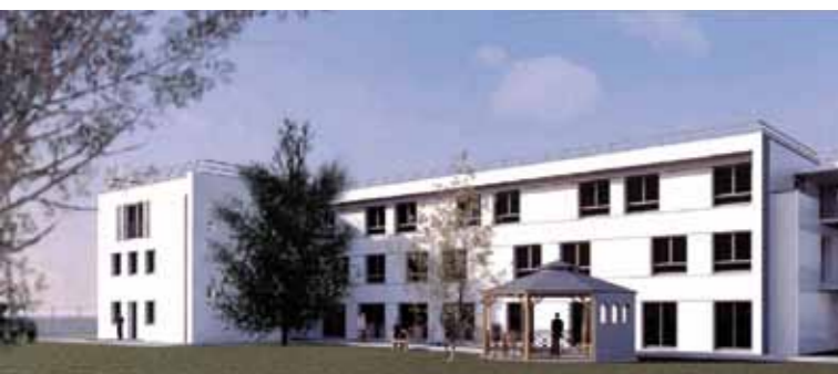
Maison des Pères Blancs à Bry-sur-Marne (94)
