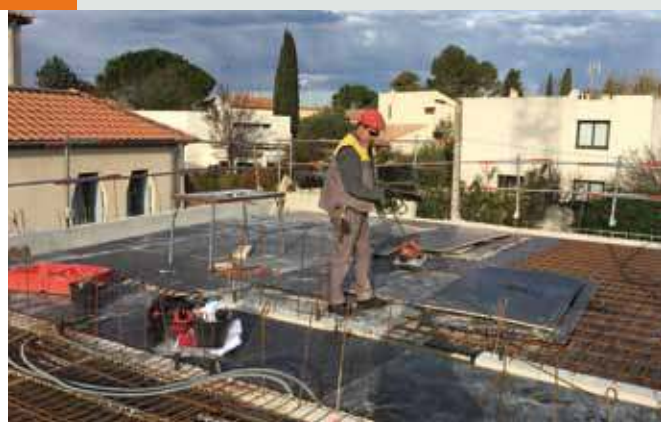
Construction d'un bâtiment bi-générationnel de 30 logements à Montpellier (34)
