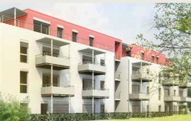
Bâtiment de 30 logements à Montpellier (34)
