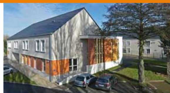
Reconstruction de l'EHPAD de Saint-Malo
