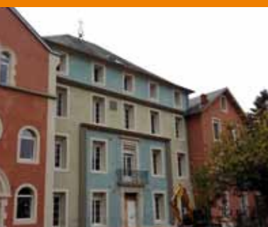
Réhabilitation de l'EHPAD de Saint-Affrique
