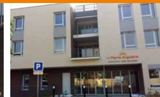
Reconstruction de l'EHPAD Bon Secours à Rillieux-la-Pape
