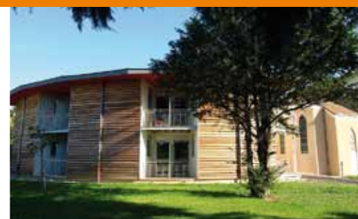
Réhabilitation de l'EHPAD de Loriot
