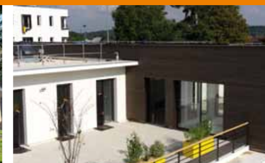
Réhabilitation/extension de l'EHPAD Lépine Providence à Versailles
