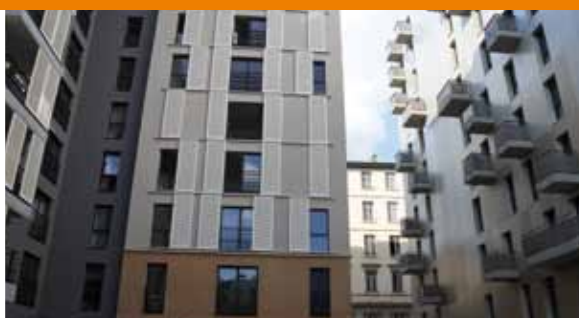
Construction sur l'ancien site des prisons de Lyon, de l'Espace Emmanuel Mounier, habitat intergénérationnel et solidaire
