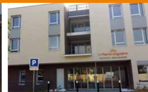
Reconstruction de l'EHPAD Bon Secours à Rillieux-la-Pape
