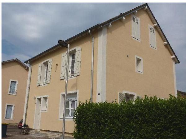
Pour la maison de Châtenoy-le-Royal, photo jointe, les travaux viennent de se terminer, avec une isolation extérieure, et une isolation des combles et du plancher du rez-de-chaussée.
