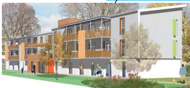
Une Résidence Intergénérationnelle de 26 logements.
