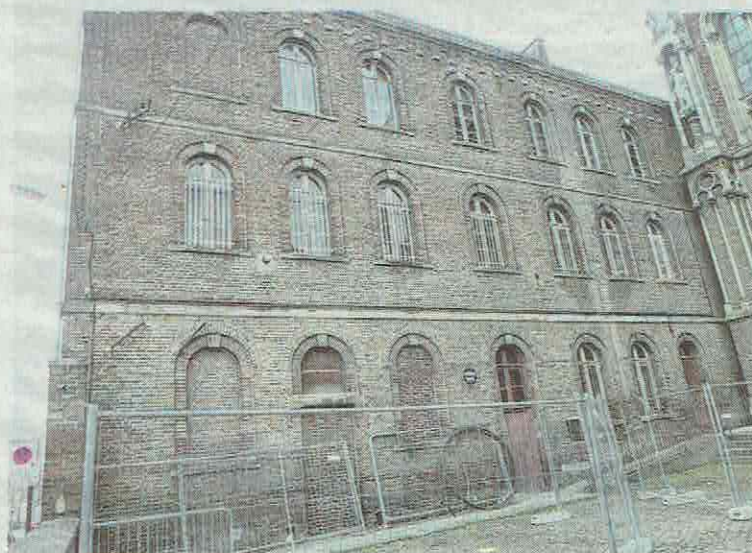
C'est dans ces locaux, ici avant travaux, qu'est installée la maison Monsieur Vincent.
