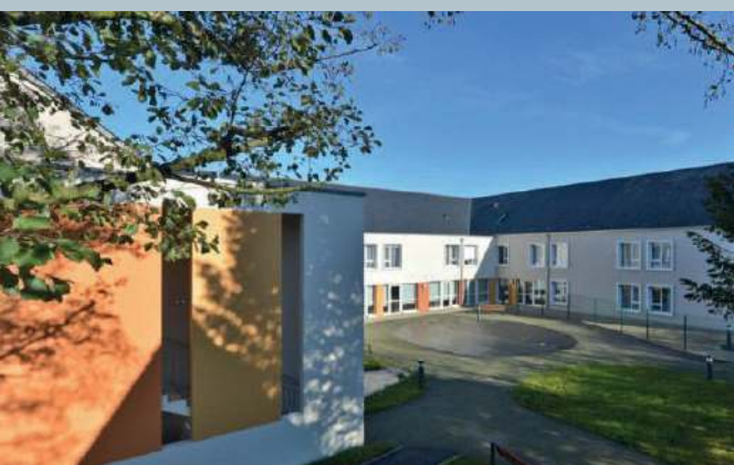
EHPAD Plessis-Pont-Pinel à Saint-Malo (35)
