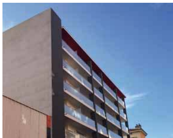
Un petit collectif de 7 logements en VEFA à Nice
