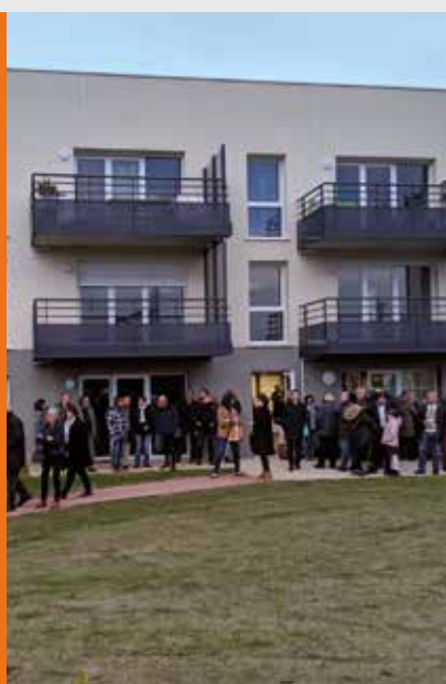
Résidence intergénérationnelle "Bellamira" à Vernon (27)
