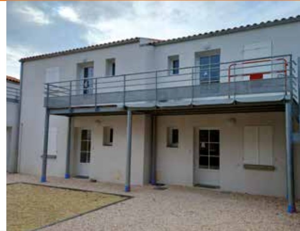
Logements à Saint-Georges d'Oléron (17)
