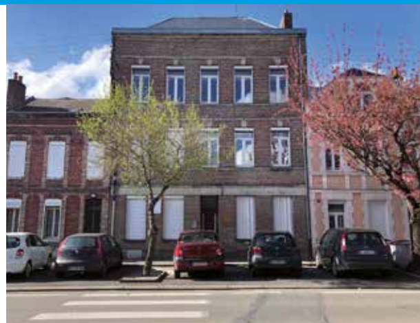
Logements à Saint-Quentin dans l'Aisne (02)
