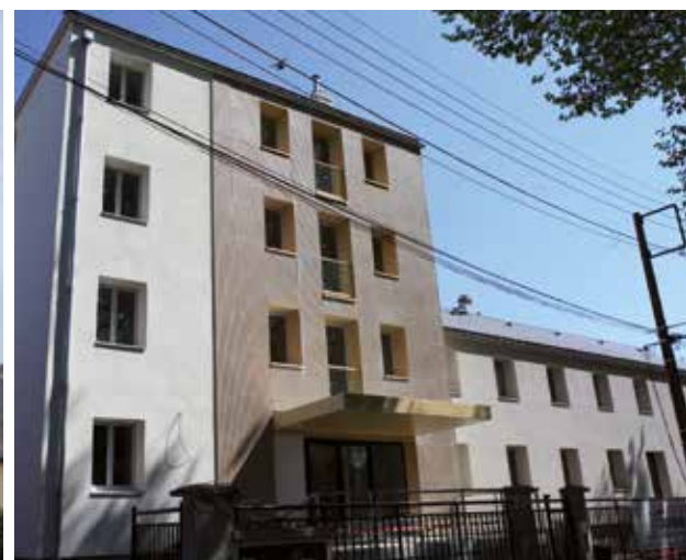
Résidence intergénérationnelle "Saint-Martin au Val" à Chartres (28)
