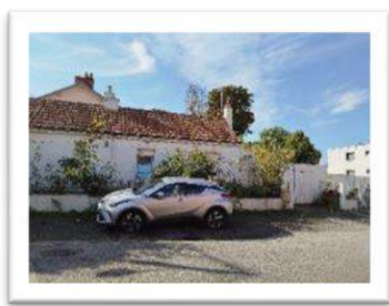
Maison du 9, à rénover
