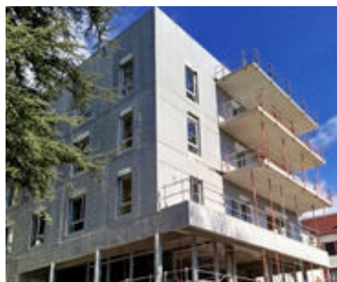
En chantier • EHPAD Saint-Germain à La Tronche (48)
